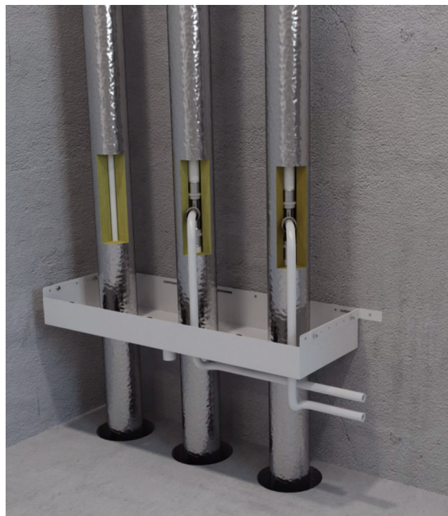
LK Schaktbotten SECURE monterad i schakt.
